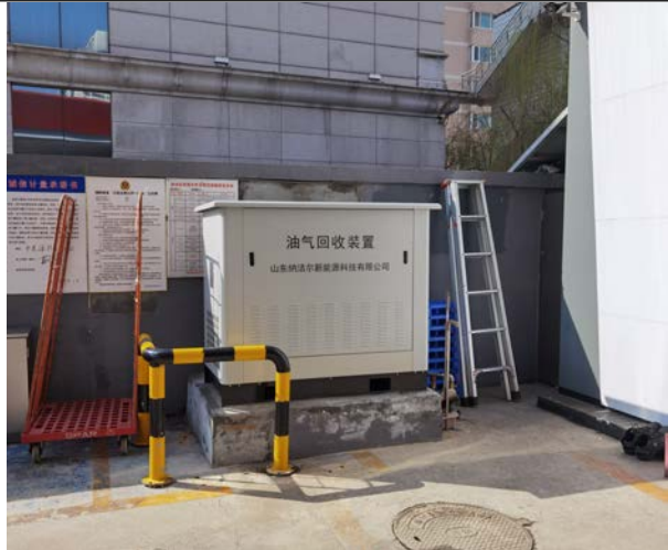
三次油气回收装置
